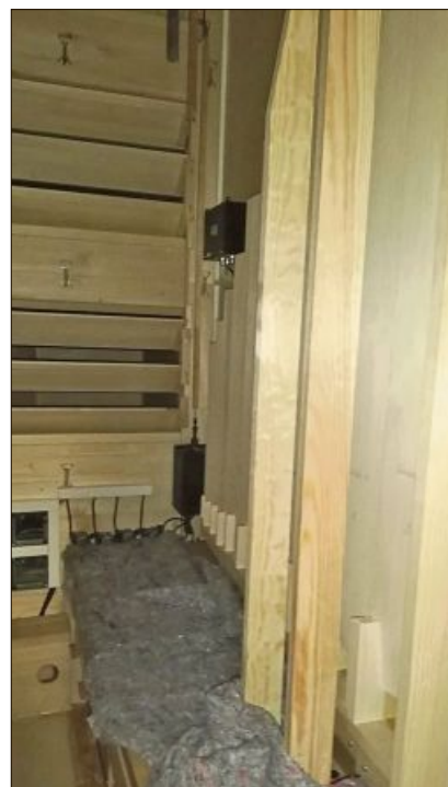
Ein Mitarbeiter der Firma Eule arbeitet im Fernwerk. Hinter ihm kann man gut die drehbaren Lamellen erkennen, mit denen der Orgelspieler die Lautstärke stufenlos regulieren kann. – Die ersten Pfeifen sind schon montiert. – So sieht der Kasten des Fernwerks bei geschlossener Tür aus.
