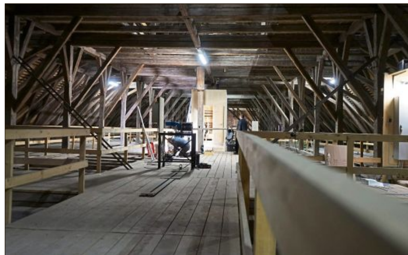
Blick in den Dachstuhl der Basilika.
